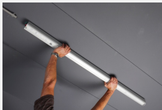
Stap 8 : Druk het boven profiel vast tot "klik"
