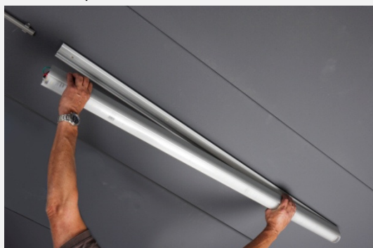
Stap 7 : Plaats het boven profiel
