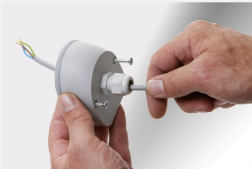
Stap 5 : Voer de kabel in de wartel
